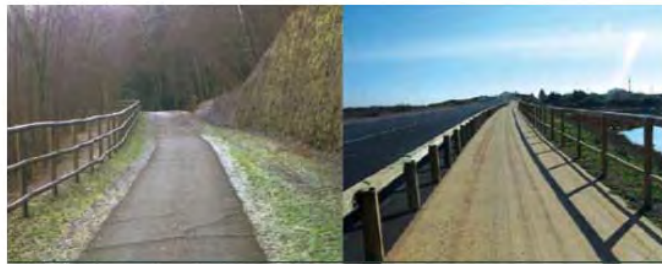
Imatge 4. Barreres de contenció de fusta en vies ciclistes. Font de les dades: Manual de disseny de les vies ciclistes. Generalitat de Catalunya.
