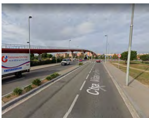
A-7 a Vilaseca. Pont sobre via principal.
