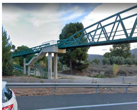
Pont sobre carretera Alcoi / Cocentaina.
